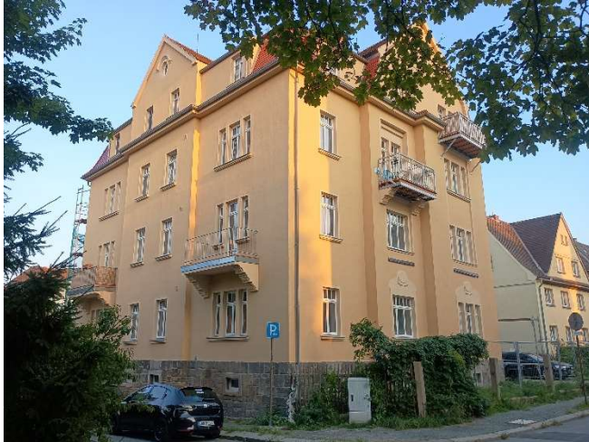
Das Mehrfamilienhaus an der Robert-Berndt-Straße in Löbau ist fast fertig saniert
