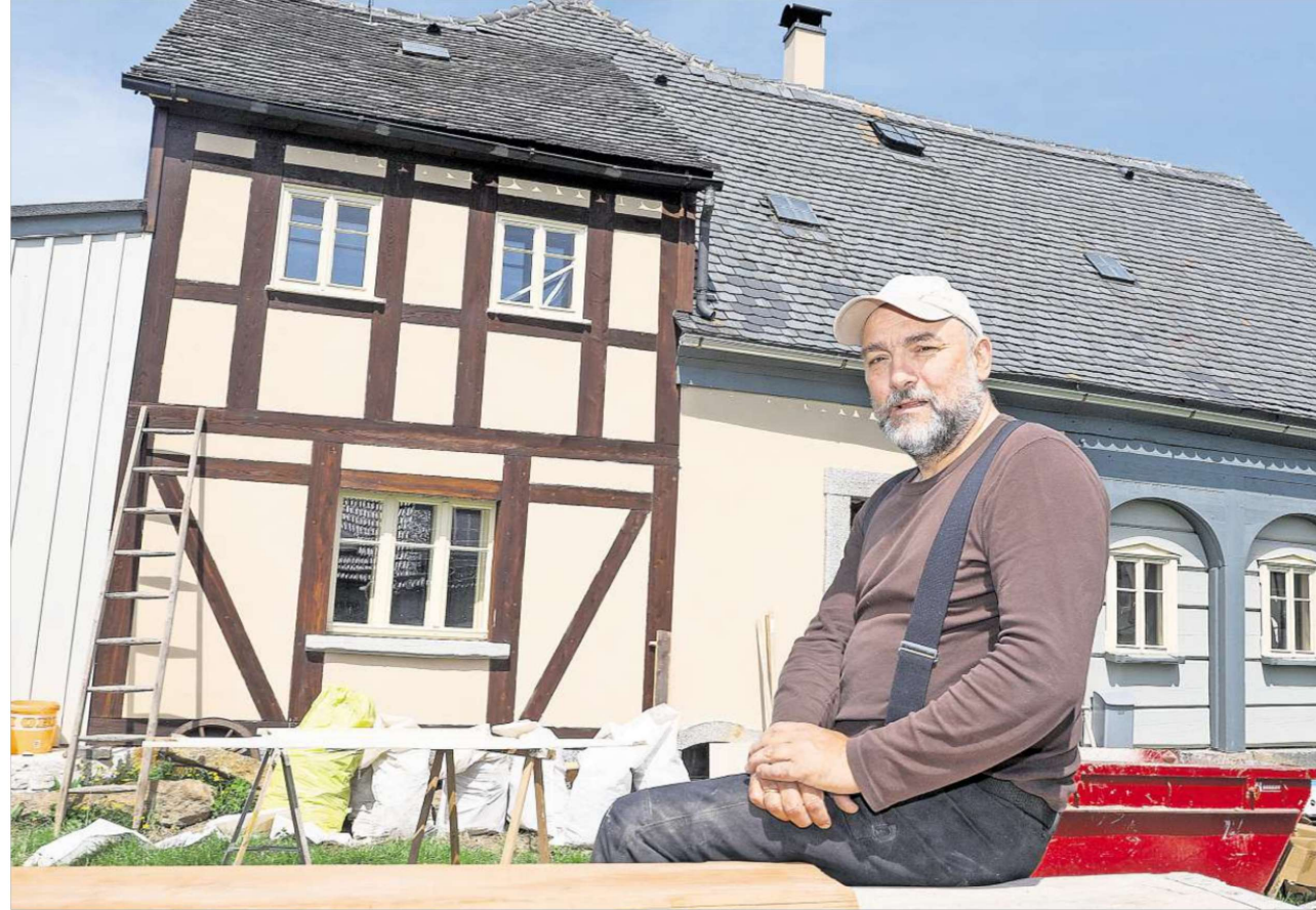
Thomas Schubert hat das Umgebindehaus am Feldweg 1 in Oppach mit der Hilfe von Freunden saniert. Zum Tag des offenen Umgebindehauses kann es jeder besichtigen. Gemeinsam mit Künstlerfreunden gestaltet der Hausherr an diesem Tag ein abwechslungsreiches Programm. FOTOS: RAFAEL SAMPEDRO
