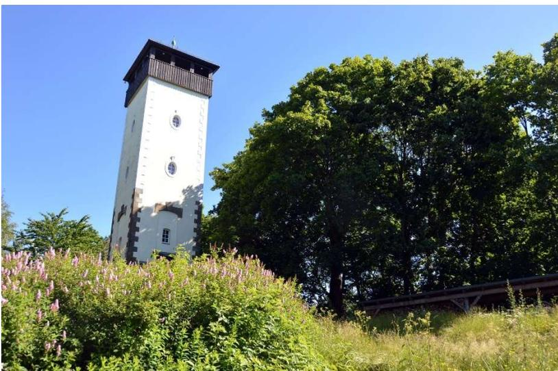
Der 18 Meter hohe Bielebohturm steht unter der Obhut des Bieleboh-Vereins. Als nach der Wende eine Sanierung bevorstand, entschloss man sich, den Turm um sechs Meter zu erhöhen.
