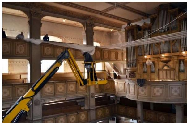
Von der Hebebühne aus werden die Netze angebracht.
