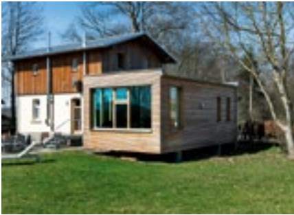
Holzverkleidungen sind das Verbindungselement zwischen Alt und Neu.
