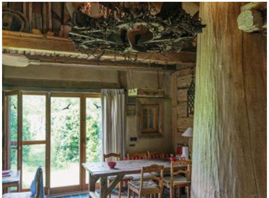
Auf dem beeindruckenden Stamm einer Schwarzpappel (rechts) ruht das Obergeschoss.
